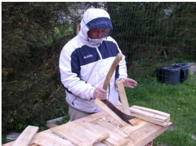
Triage et préparation des bardeaux de rives avec le coudre
