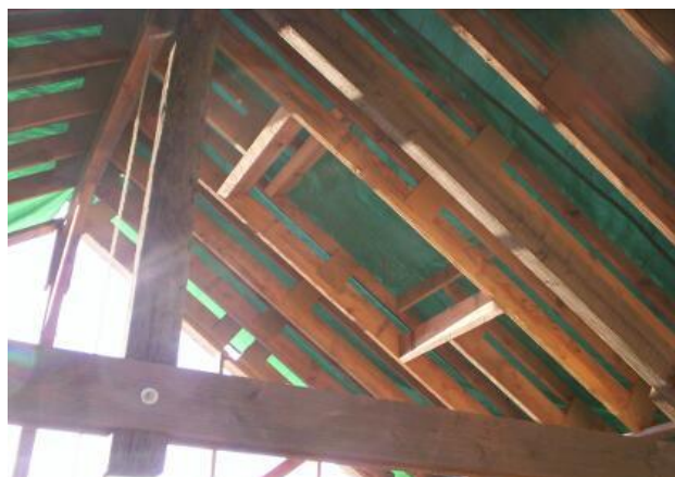
Fabrication et pose des pannes de dépassés de toit, après le chevronnage
