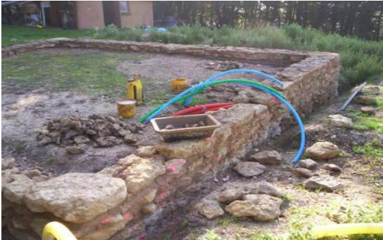
Arrivée des réseaux sous les fondations en pierres (25 t.)
