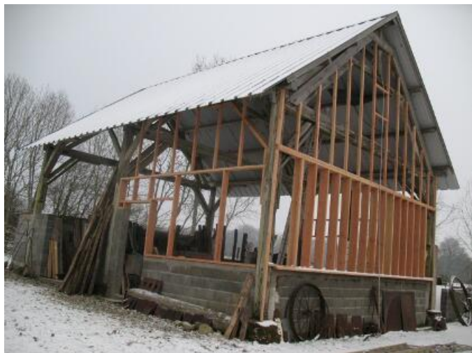
La structure secondaire est posée, insérée dans la structure en poteaux-poutres.
