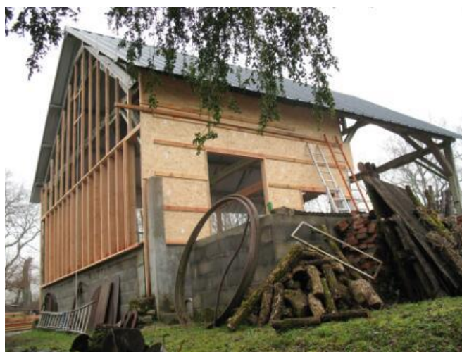
La structure secondaire est posée, insérée dans la structure en poteaux-poutres.
